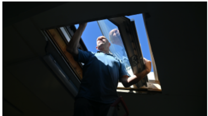
Inmiddels heeft een nieuwe, en tevens voor Jason reeds bekende aannemer het verbouwingskarwei op zich genomen. Op gebied van de elektriciteit hebben bekwame leden al heel veel aangepakt. Ledverlichting en sensoren moeten de kosten gaan drukken op gebied van de electriciteit. De dakramen moeten in de kleedkamers nog worden aangebracht.
