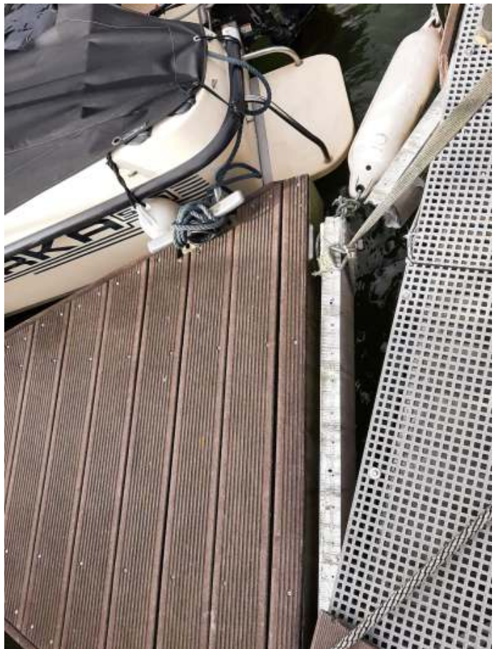
Ook op de steigers valt er altijd wel iets te repareren. Daar ontfermen vrijwilligers van ZM zich over. Soms moet iets buiten Jason worden gerepareerd, bijv. bij Helldorfer lasbedrijf of bij scheepsreparatiebedrijf Arnhem.
