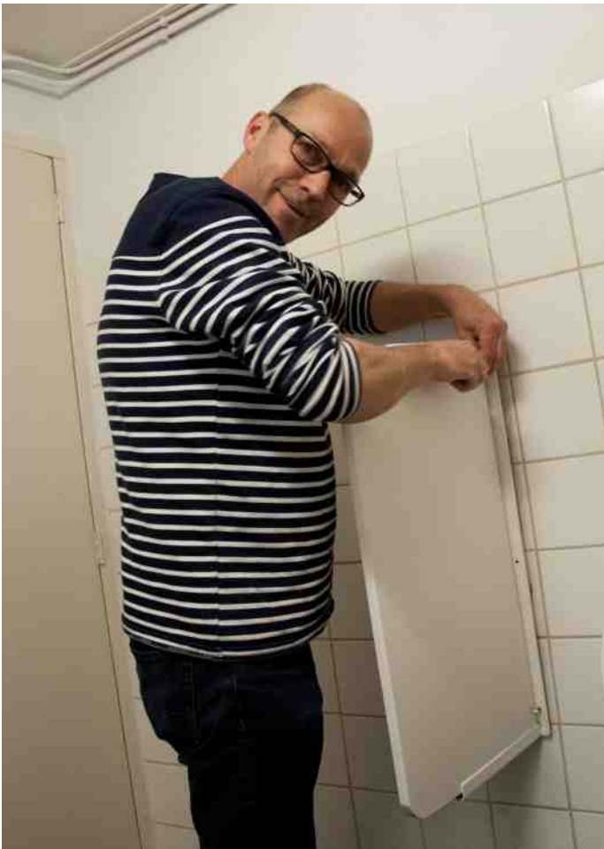
Hans heeft de schotten bij de piskakken gelast en een nieuw verfje gegeven. Ziet er weer fris uit.
