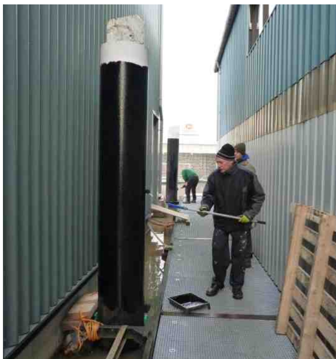
Hoog water biedt ook mogelijkheden voor onderhoud van de steigerpalen. De bovenkant is dan gemakkelijk te bereiken met de teerkwast en het weer witten van de hoed. Inmiddels staat er op een van de steigerpalen ook een witte lijn met de hoogste stand van het water dat dit jaar is gemeten met hoogwater.
