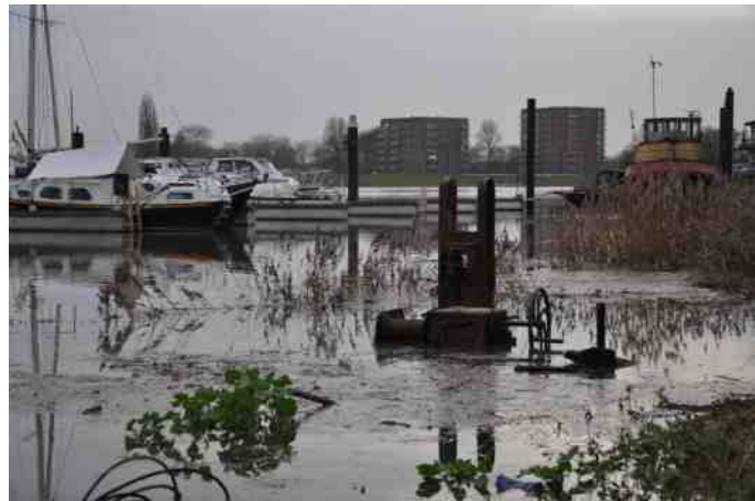
Westkant van clubgebouw. De ontmantelde oude kraan lijkt nu een modern kunstwerk in het water. De vraag was of uiteindelijk de loods op de wal ook in het water zou komen te staan. Dat was gelukkig niet het geval. Voor de zekerheid waren de botenwagens wel op de oprit gezet zodat zij in geval van nood gemakkelijk weg te slepen waren.
