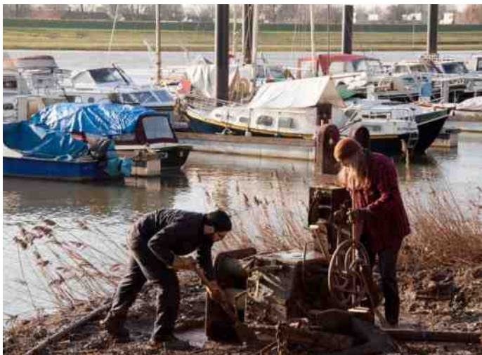
De Stichting Stadsblokkenwerf heeft de oude kraan gekregen voor herplaatsing op het terrein van de voormalige ASM scheepswerf alwaar momenteel door vrijwilligers een kleinschalige historische scheepswerf wordt opgericht. Wat rest is het voetstuk van de oude kraan nog op de plaats van bestemming te krijgen.
