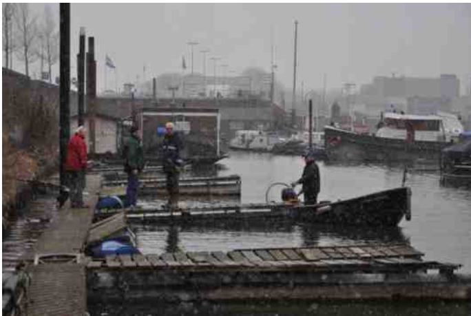
Afbraak jollensteiger in 2013 om kunstofsteigers daarvoor in de plaats aan te leggen.
